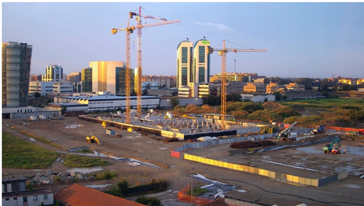
Stato ad oggi del cantiere SeiMilano
